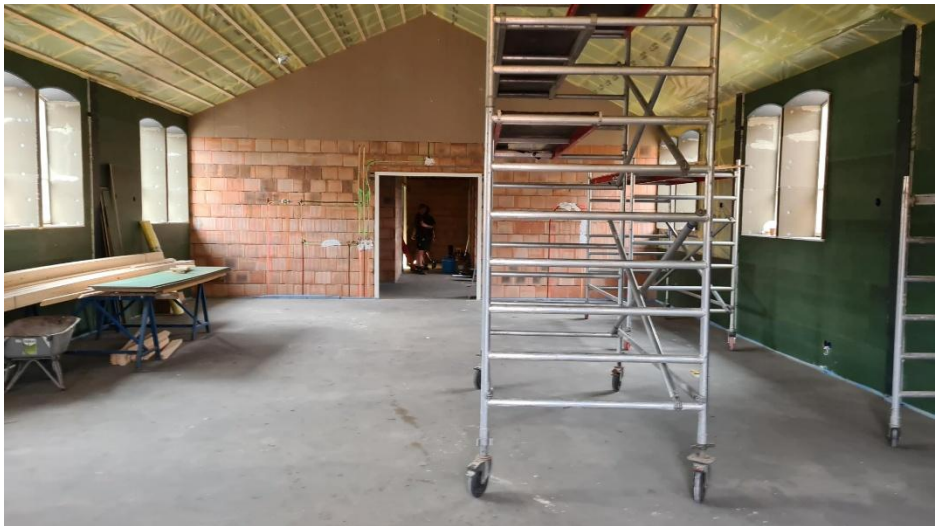
De kerkzaal met de nieuwe vloer, voorzien van vloerverwarming
