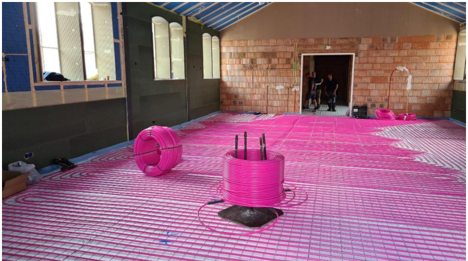
De vloerverwarming in de kerkzaal is aangebracht.
