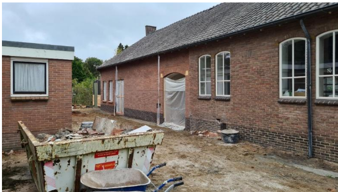
Zijkant met nieuwe ingangen
