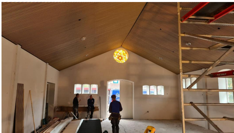
Het plafond zit er bijna in. Het glas-in-loodraam is prachtig zichtbaar.
